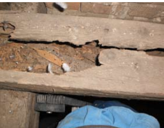
Vályúsán kikorhadt szelemen az attikafal alatt
