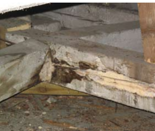
Beázás és biológiai károsodás nyomai egy megerősített kötőgerendán
